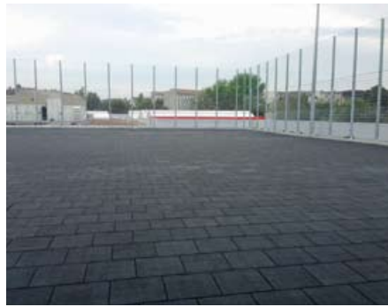
▲ Hier ist das Spielfeld bereits vollständig mit der elastischen Bautenschutzplatte ausgelegt
