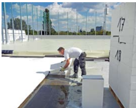
▲ Die Dämmplatten wurden dann direkt in die Dampfsperre eingelegt und press gestoßen
