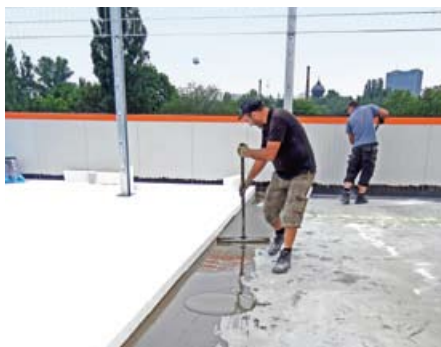
▲ Auf dem Beton wurde zunächst jeweils eine Bahn der Flüssigdampfsperre aufgebracht
