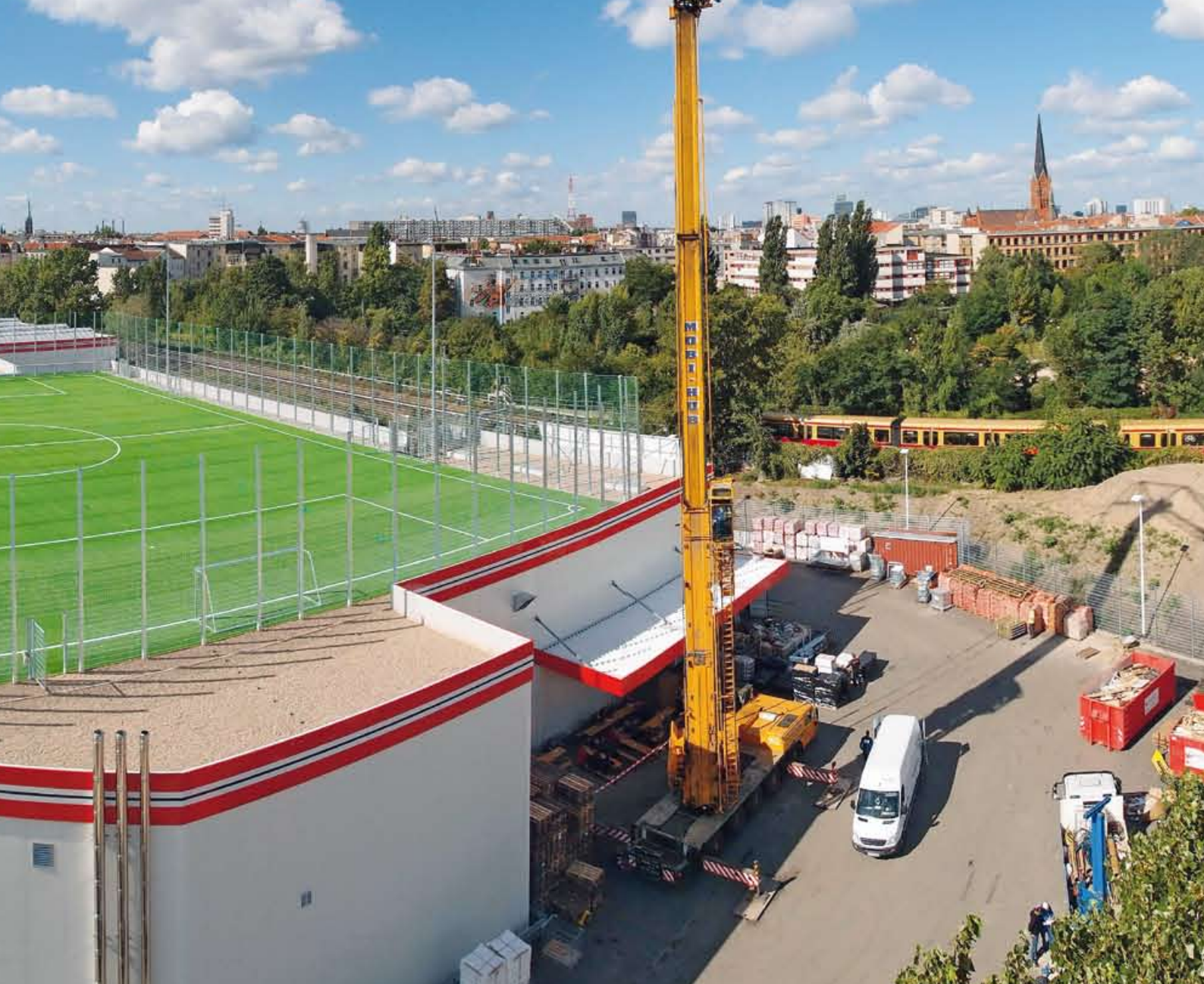
▲ Auf dem Dach eines neu gebauten Baumarktes in Berlin steht den Kindern jetzt ein Fußballplatz zur Verfügung
