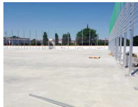
▲ Danach wurde die gesamte Fläche mit lose verlegten PVC-Dichtungsbahnen abgedeckt
