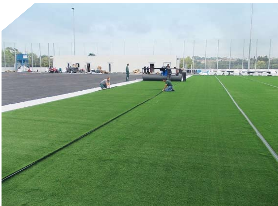
▲ Am Ende verlegten die Handwerker den Kunstrasen, der speziell für Sportplätze entwickelt wurde
