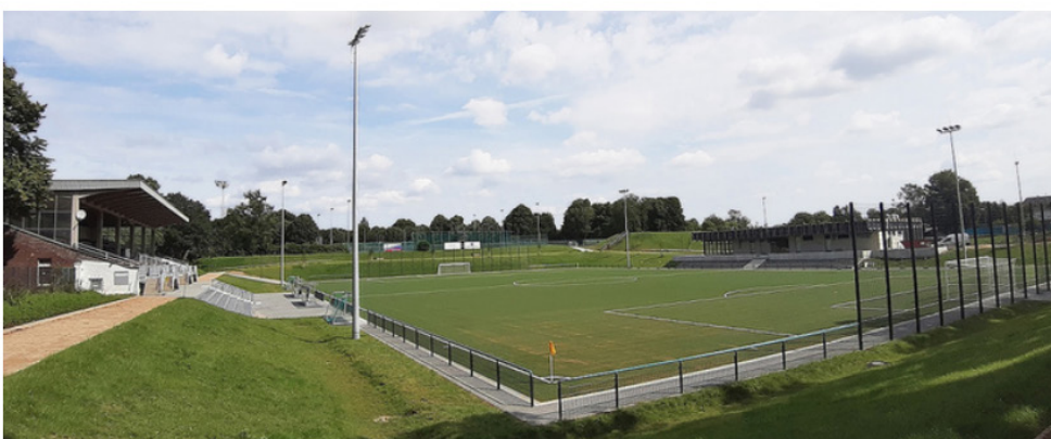
Nach zwei Jahren Bauzeit wurde der Campuspark Rheydt eröffnet. Er umfasst zwei neue Kunstrasenplätze sowie ein Mehrzweckgebäude. Foto : Holger Hintzen
